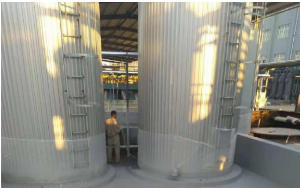
喷涂聚脲防水涂料的比重，聚脲标准里面没有规定，拿比重和水接近的配方来说，，出1mm厚度是大多数聚脲防水涂料的理论用料量，实际喷涂中，我们要考虑20%左右的损耗，也就是说要，用在1平方米上，出1mm厚度。这里说的1mm是平均厚度，也许比较低的地方只有，都是可能的，对于这种机器一次喷出的厚度来说，也是正常的。市场上，比如德士力，会有一些创新型聚脲配方，厚度则不可这么计算，比如直接外露型屋面聚脲配方里面，添加的有吸收紫外线成分，产品比重就会增加，耐紫外线能力同样也会增加，相应的，每平米出1mm厚度的用料量，也会增加。不能一概而论，这是很简单的道理。水，会让聚脲涂料严重发泡，变成聚氨酯泡沫，因此水是无法加到配方里面的。甘肃桥梁聚脲材料山东德士力新材料科技有限公司的追求是诚信为本，塑造品牌。
